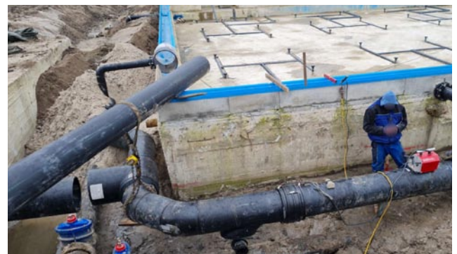
Montage der Beckenverrohrung
